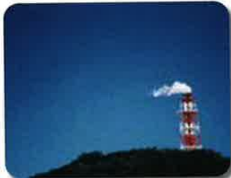
着色煙対策後
